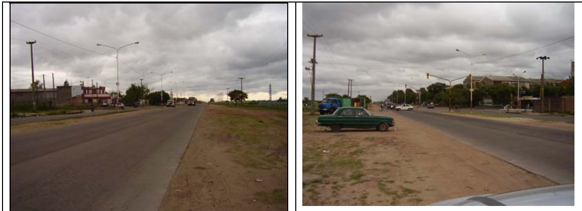
Características de la Av. Soberanía Nacional acceso vial a la Planta
